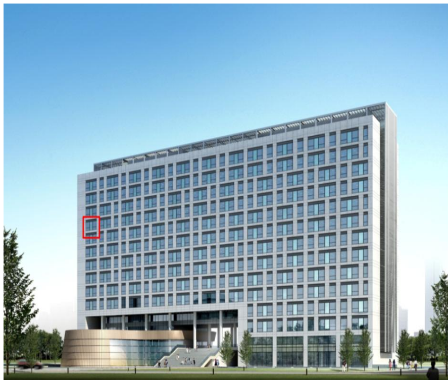
基础研究大楼数据中心
